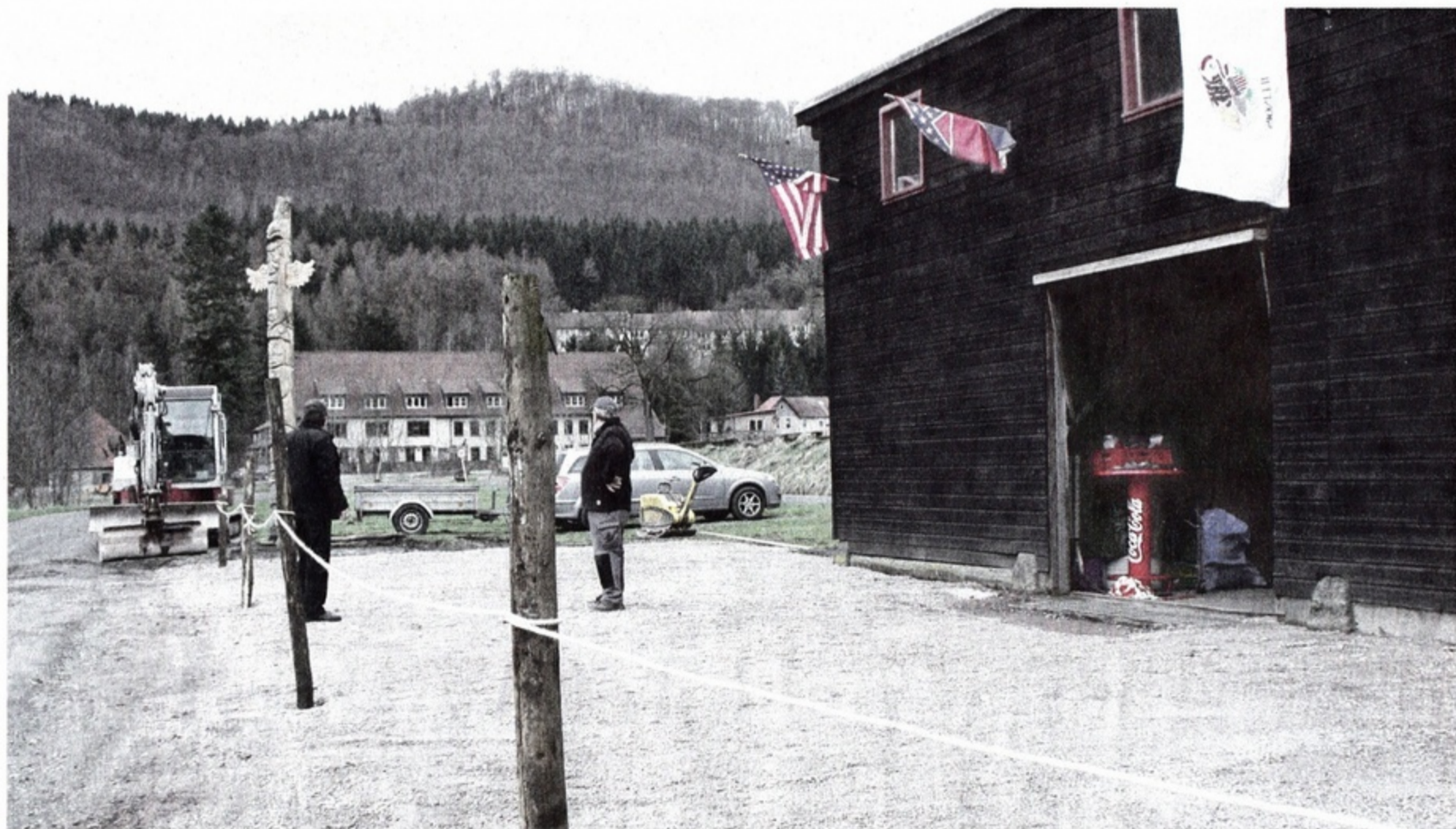
Die Bauarbeiten vor der Ranch haben am Montag begonnen und sollen bis Himmelfahrt abgeschlossen sein.
